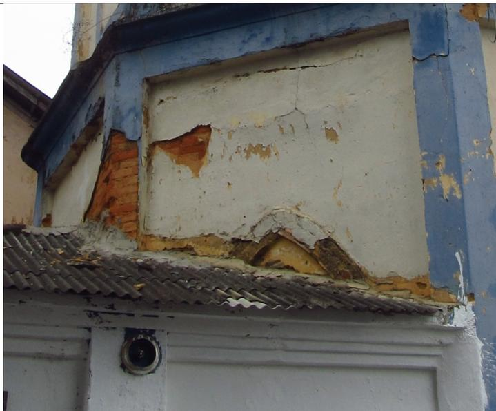
Figura 14 – Danos causados à edificação com a vedação de vão de iluminação e danos nas alvenarias para inserção da cobertura em fibrocimento.
