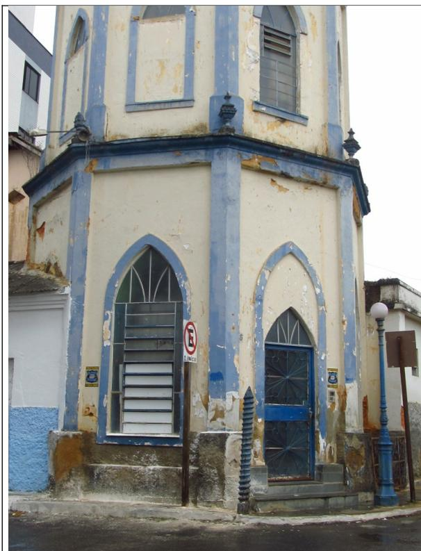
Figura 15 – Vedação e alteração de vãos e pintura dos vidros das esquadrias.
