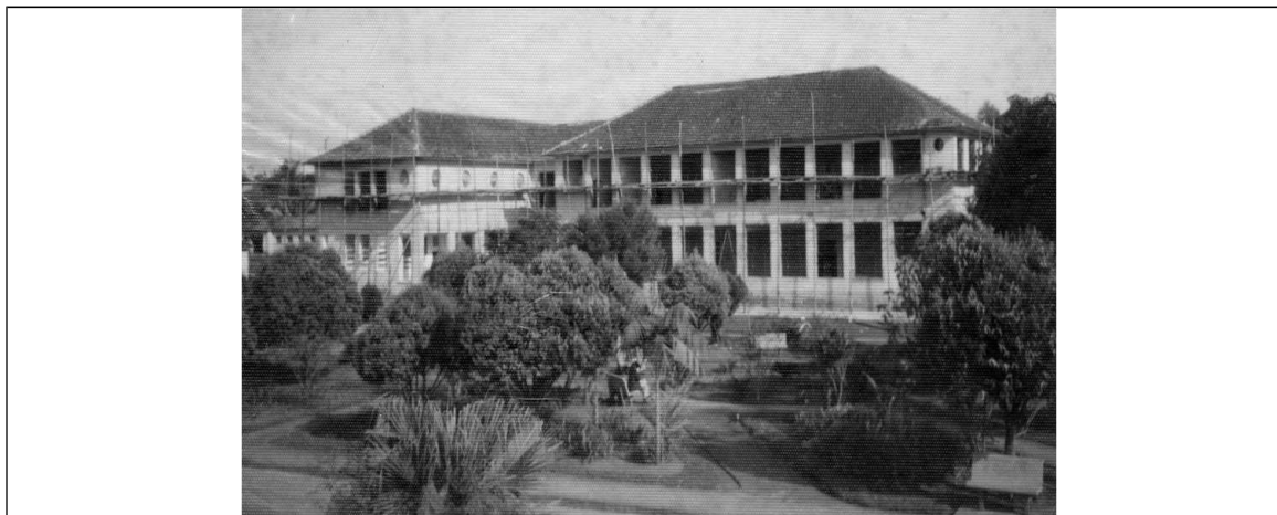
Figura 7 - Vista externa da construção da Colônia São Francisco de Assis. Fonte: foto enviada por e-mail pelo Núcleo de Ensino e Pesquisa da Casa de Saúde São Francisco de Assis. Acesso em: 20-02-2017.
