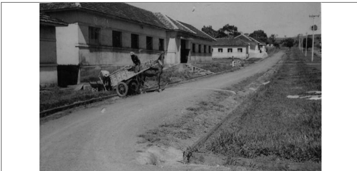
Figura 9 - Vista externa da construção da Colônia São Francisco de Assis. Fonte: foto enviada por e-mail pelo Núcleo de Ensino e Pesquisa da Casa de Saúde São Francisco de Assis. Acesso em: 20-02-2017.
