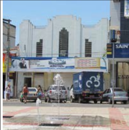
Figura 10 – Edificação do antigo Cine Brasil, inventariado pelo município. Fonte : Ficha de inventário.
