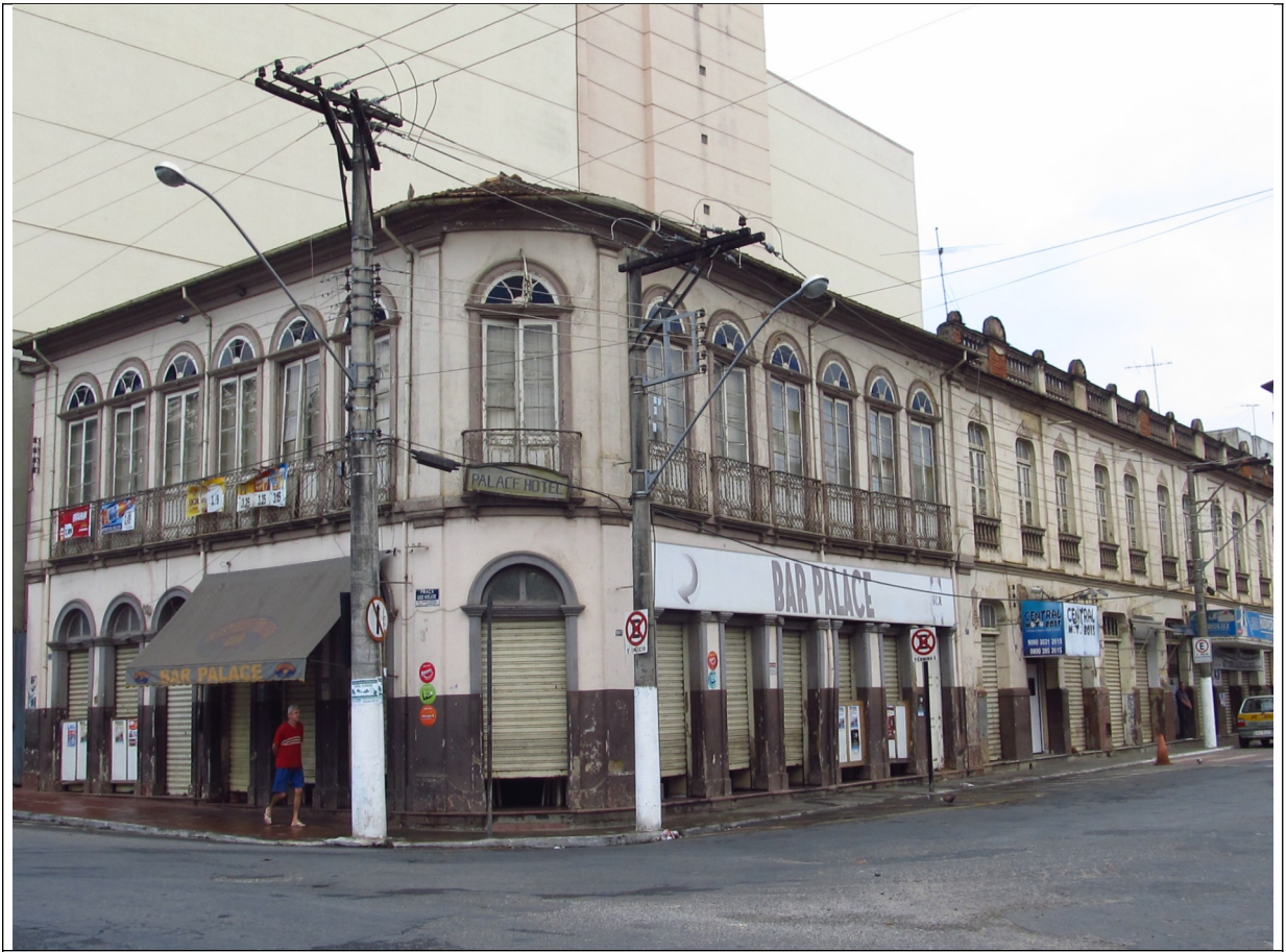
Figura 12 – Antigo Palace Hotel. Fonte: Fotos da vistoria.
