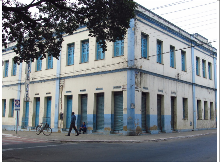
Figura 11 – Grande Hotel. Fonte: Fotos da vistoria.
