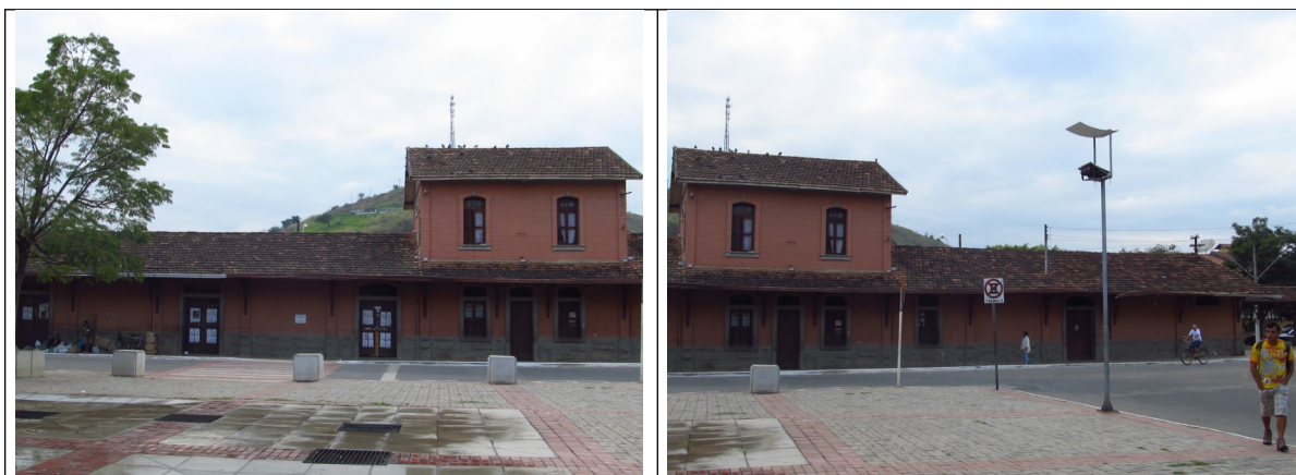
Figuras 16 e 17 – Praça Guido Marlière com a Estação Ferroviária ao fundo. Fonte: Fotos da vistoria.
