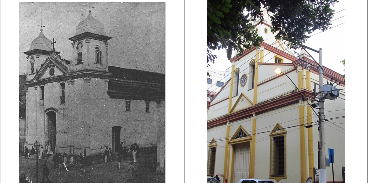
Figuras 06 e 07 - Imagem antiga e atual da Igreja Matriz de São Januário. Fonte: Fotografia disponibilizada pelo Arquivo Histórico da Cidade de Ubá e foto da vistoria.
