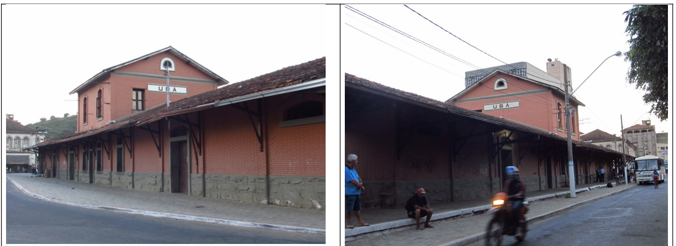
Figuras 11 e 12 – Fachadas frontal e posterior da estação. Fonte: fotos da vistoria.
