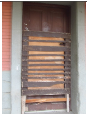
Figuras 18, 19 e 20 – Danos nas esquadrias. Fonte: fotos da vistoria.
