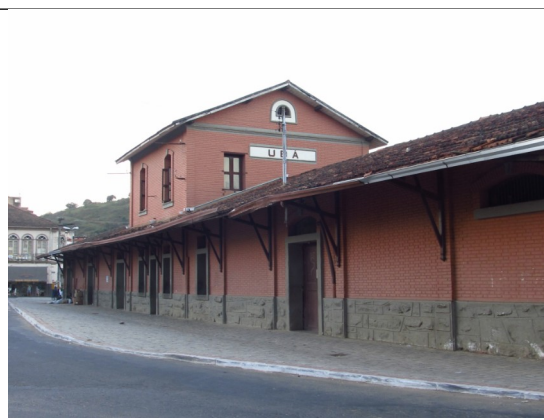
Figura 29 – Foto da vistoria de 08, 09 e 10 de julho de 2013.
