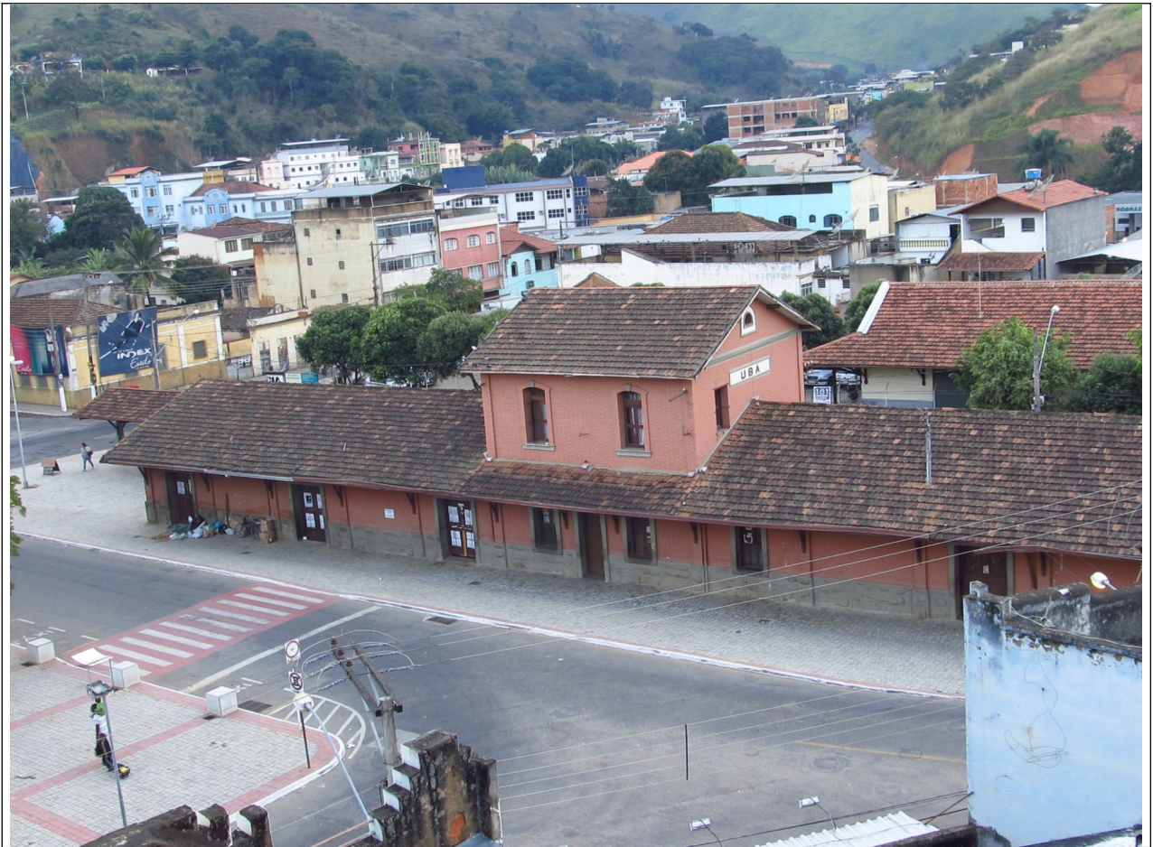
Figura 10 – Vista geral da Estação Ferroviária de Ubá. Fonte: fotos da vistoria.
