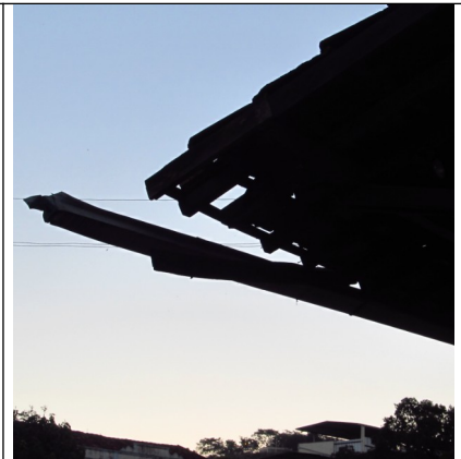
Figuras 15, 16 e 17 – Calhas e condutores soltos e oxidados, favorecendo a existência de umidade nas alvenarias. Fonte: Fotos da vistoria.
