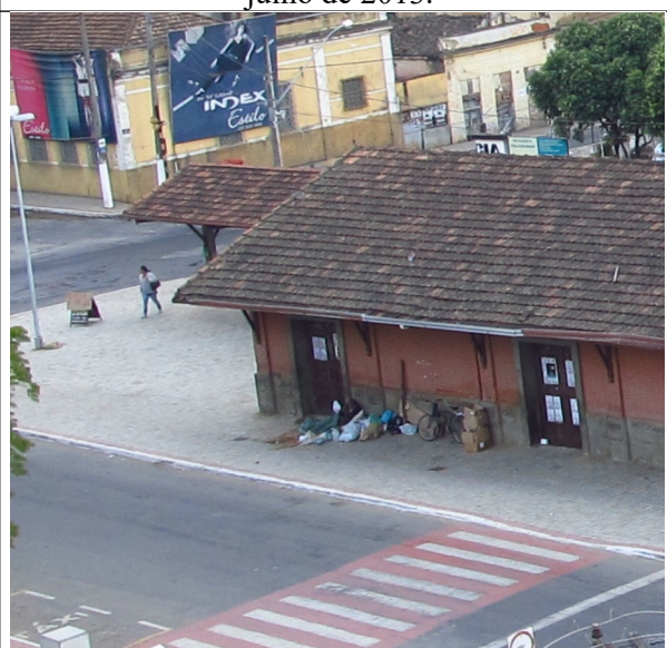
Figura 34 – Foto da vistoria de 08, 09 e 10 de julho de 2013.
