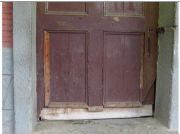
Figuras 18, 19 e 20 – Danos nas esquadrias. Fonte: fotos da vistoria.
