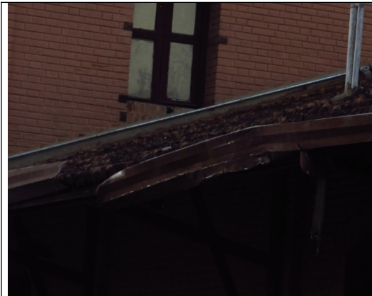
Figuras 15, 16 e 17 – Calhas e condutores soltos e oxidados, favorecendo a existência de umidade nas alvenarias. Fonte: Fotos da vistoria.
