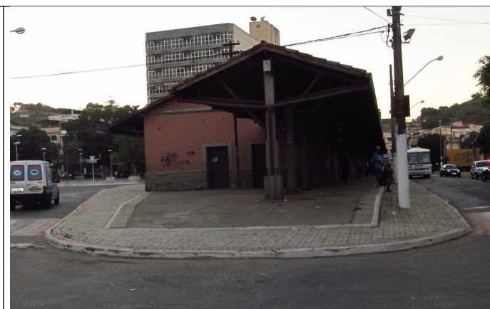
Figura 27 – Foto da vistoria de 08, 09 e 10 de julho de 2013.
