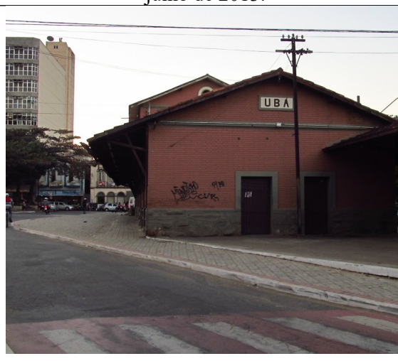
Figura 30 – Foto da vistoria de 08, 09 e 10 de julho de 2013.
