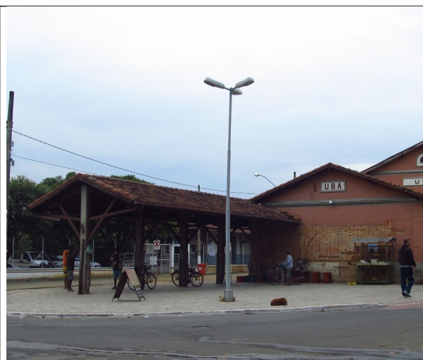
Figura 32 – Foto da vistoria de 08, 09 e 10 de julho de 2013.
