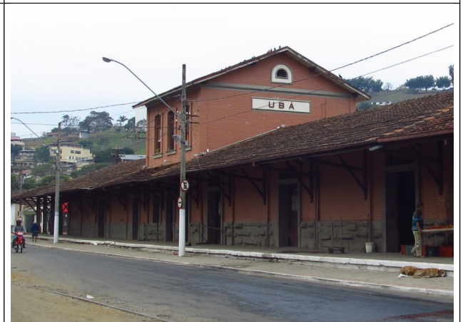
Figura 38 – Foto da vistoria de 08, 09 e 10 de julho de 2013.
