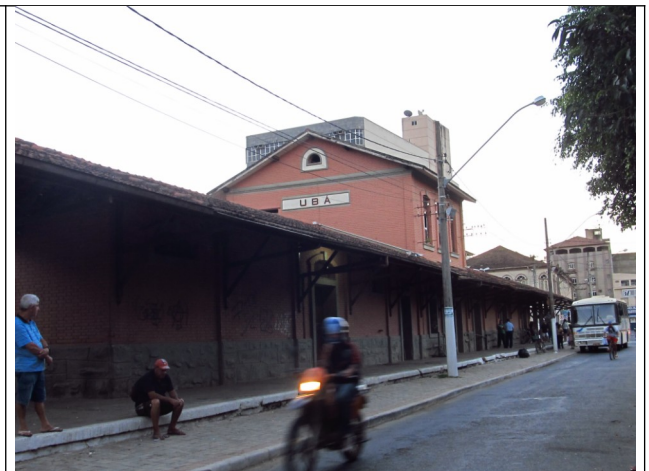
Figura 36 – Foto da vistoria de 08, 09 e 10 de julho de 2013.
