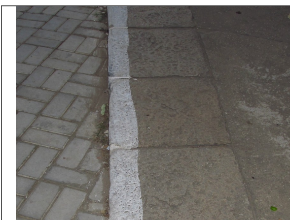
Figuras 39 e 40 – Trechos onde houve alargamento da calçada com preservação do piso original, inclusive da moldura em pedras. Fonte: Fotos da vistoria.
