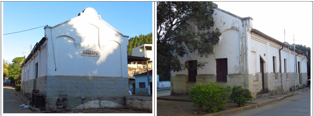
Figuras 09 e 10 – Fachadas da estação. Fonte: fotos da vistoria.
