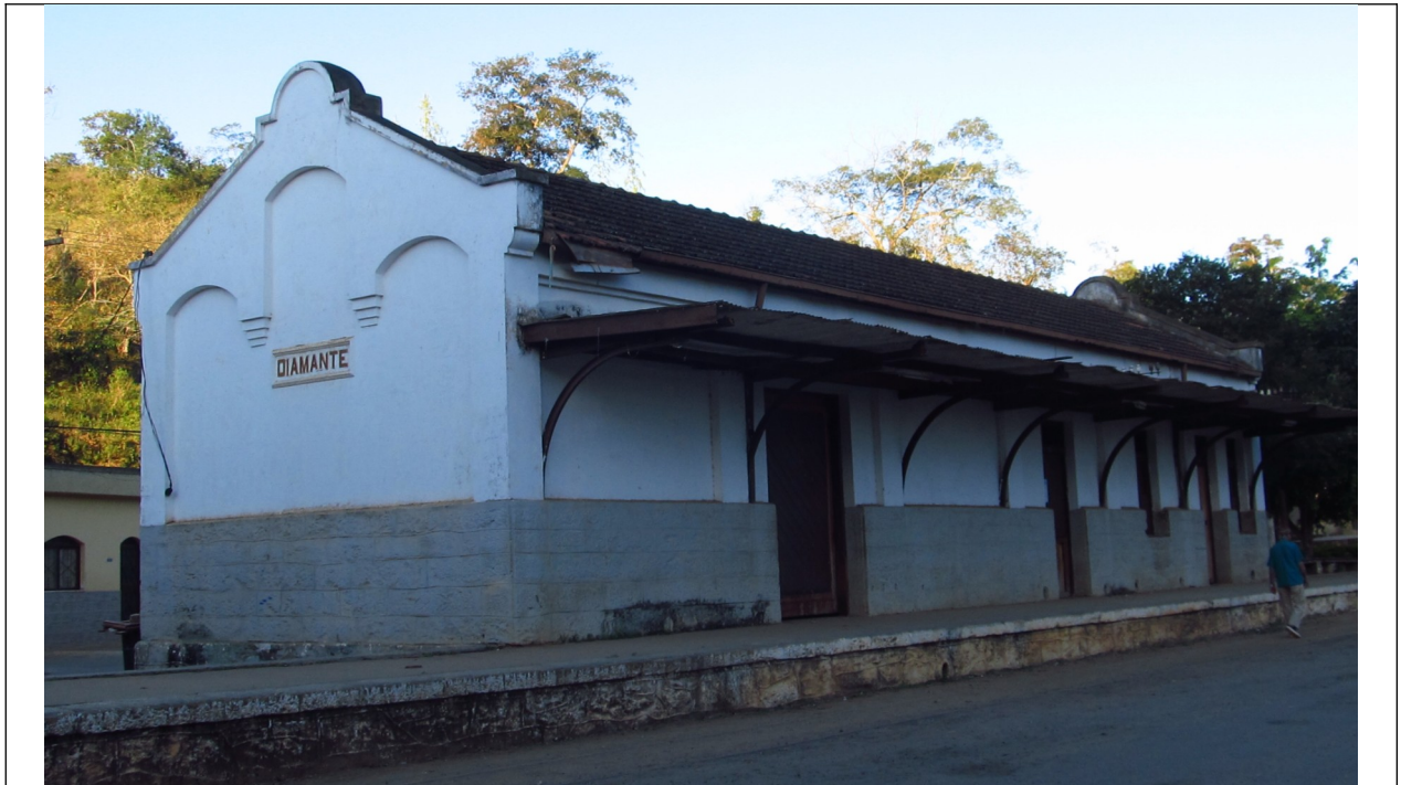
Figura 08 – Vista geral da Estação Ferroviária de Diamante. Fonte: fotos da vistoria.
