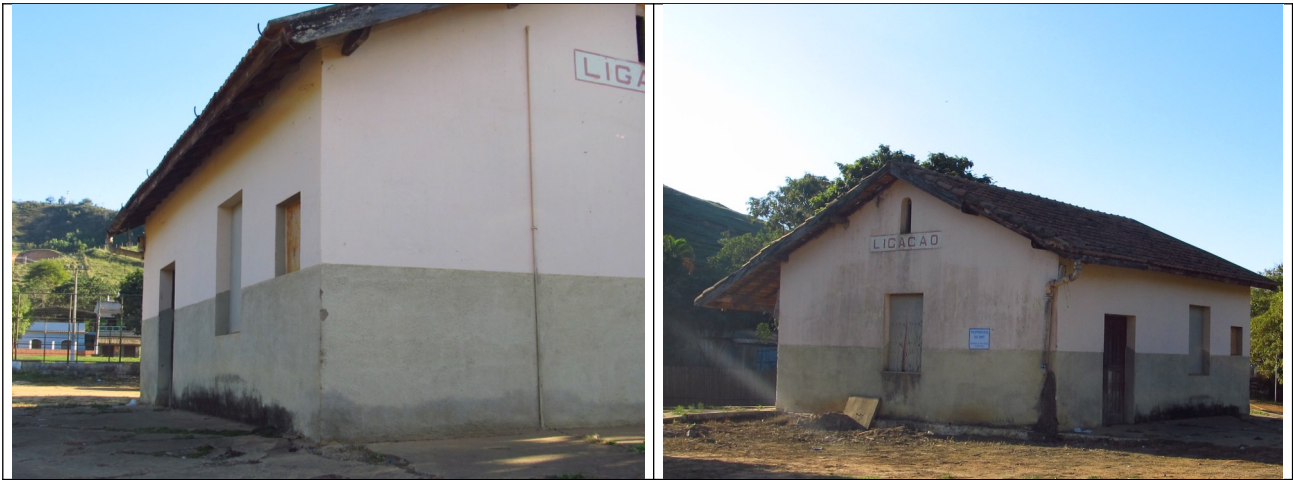
Figuras 15 e 16 – Fachadas da estação de passageiros.
