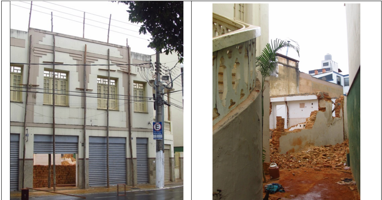
Figuras 21 e 22- Edificação em processo de demolição na Praça São Januário. Fotos da vistoria.
