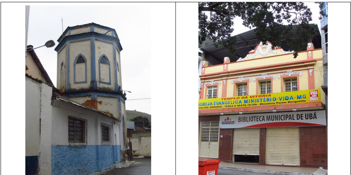
Figuras 15 e 16- Imagens de abandono e de descaracterização em bens culturais de Ubá: Torreão
