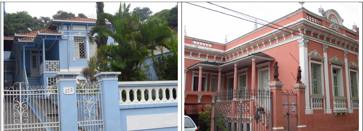
Figuras 09 e 10- Residências inventariadas em Ubá: Rua Santa Cruz, nº 579 e Rua Peixoto Filho, nº 14, respectivamente. Fotos da vistoria.
