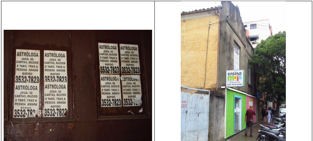
Figuras 21 e 22- Fixação de cartazes nas portas da Estação Ferroviária tombada em Ubá e utilização de cores diferentes numa mesma fachada. Fotos da vistoria realizada por este Setor Técnico no município.
