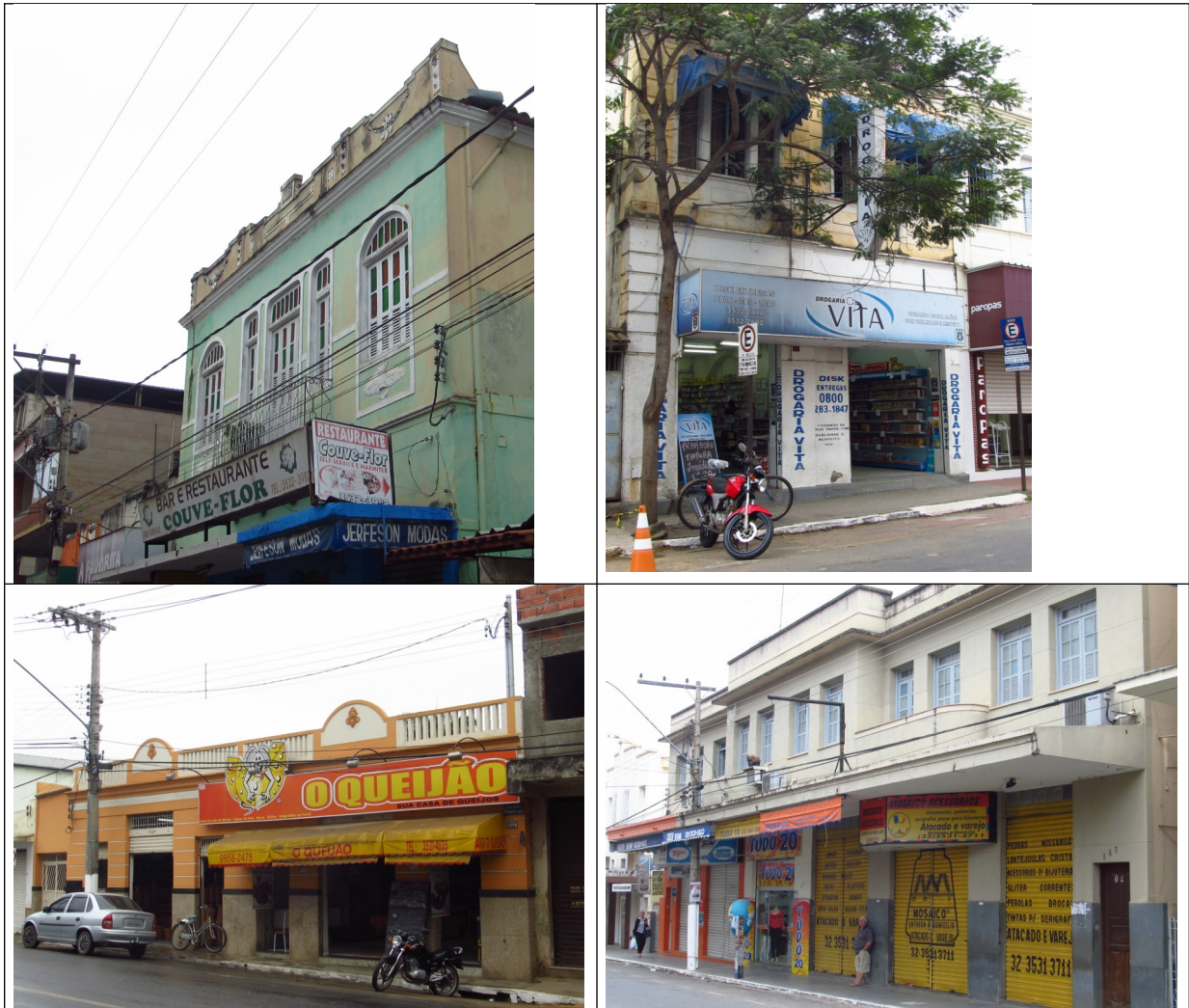
Figuras 29 e 30 -Exemplos diversos da poluição visual que agride a paisagem urbana de Ubá. Fotos da vistoria realizada por este Setor Técnico no município.
