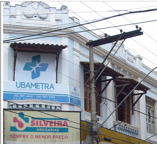
Figura 23 – Coberturas em telhas de fibrocimento sobre janela de edificação eclética.
