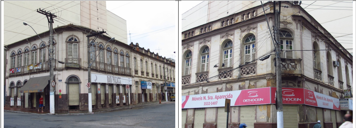
Figuras 11 e 12- Imóvel na esquina da Praça Guido Marlière com a Rua 7 de Setembro. Fotos da vistoria realizada por este Setor Técnico no município.
