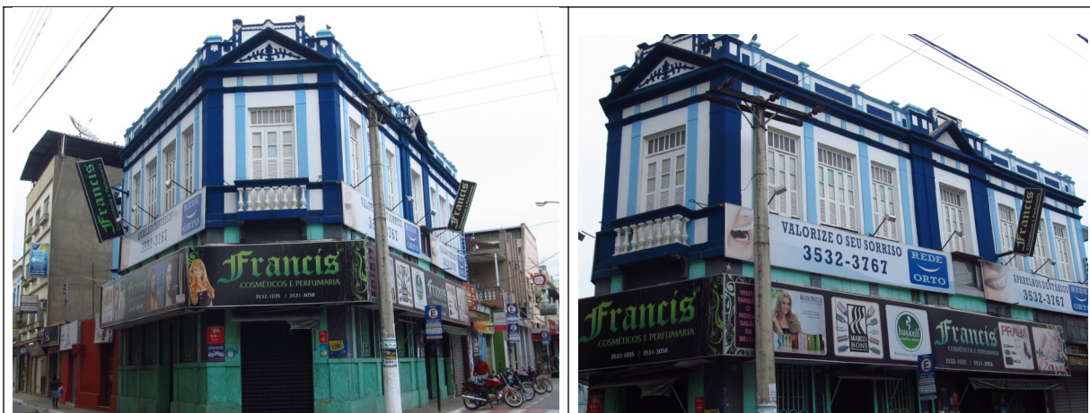
Figuras 07 e 08- Imóvel situado na esquina da Rua São José com a Rua XV de Novembro. Fotos da vistoria por realizada este Setor Técnico no município.
