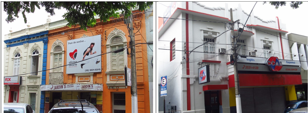
Figuras 18 e 19- Poluição visual na Praça São Januário em Ubá. Fotos da vistoria realizada por este Setor Técnico no município.
