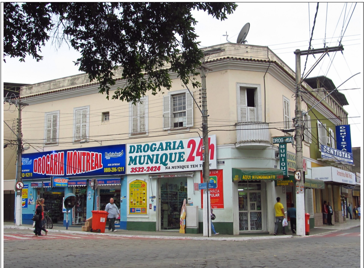
Figura 17- Imóvel situado na Praça da Independência em Ubá. Fotos da vistoria realizada por este Setor Técnico no município.
