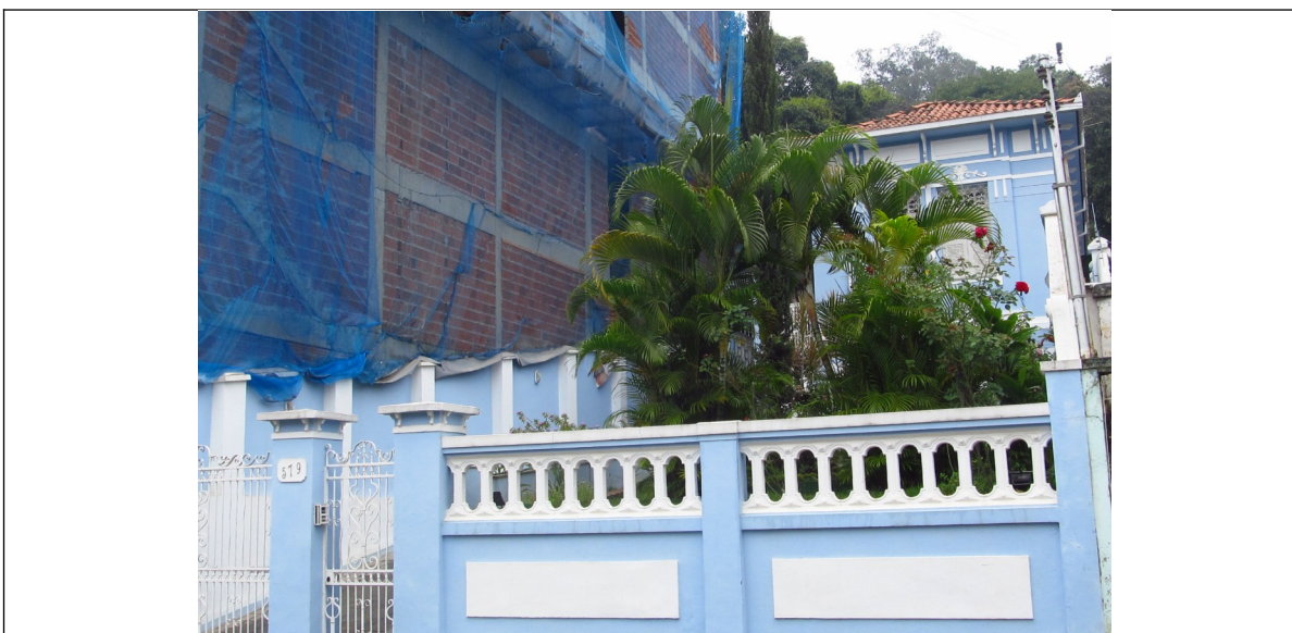
Figura 06- Construção de um prédio bem ao lado da residência inventariada em Ubá. Foto da vistoria.
