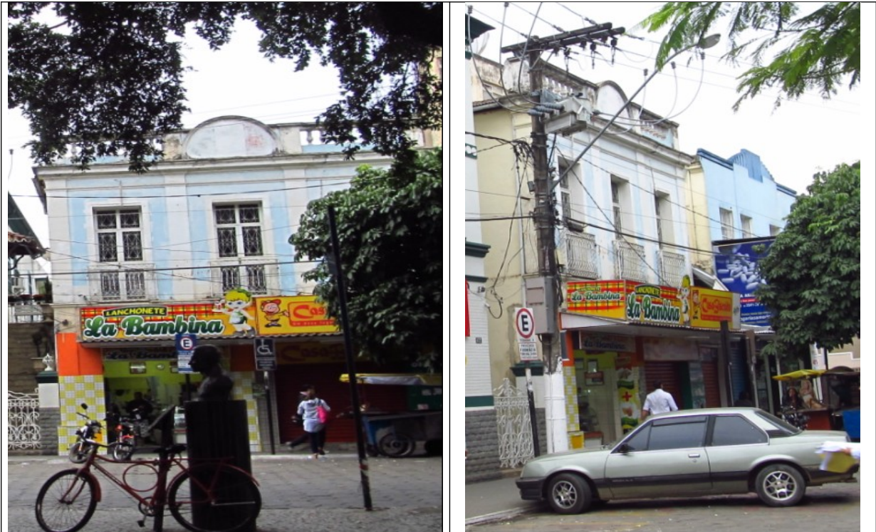
Figuras 07 e 08 - Imagem atual do imóvel que abrigou a Sociedade Ítalo-Brasileira em Ubá, com a presença de cobertura e placas publicitárias em sua fachada. Foto da vistoria..
