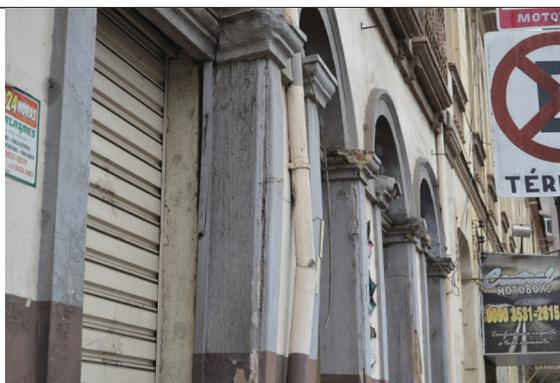
Figura 24 – Trinca no encontro dos planos de alvenaria.
