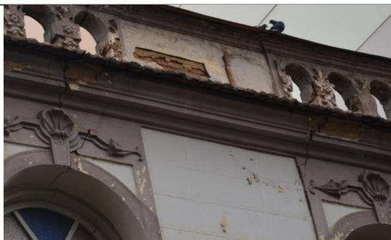
Figura 25 – Estufamento existente no pavimento térreo, a ser apurado.
