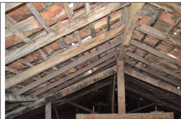
Figura 28 – Aspecto geral do engradamento da cobertura, em regular estado de conservação.
