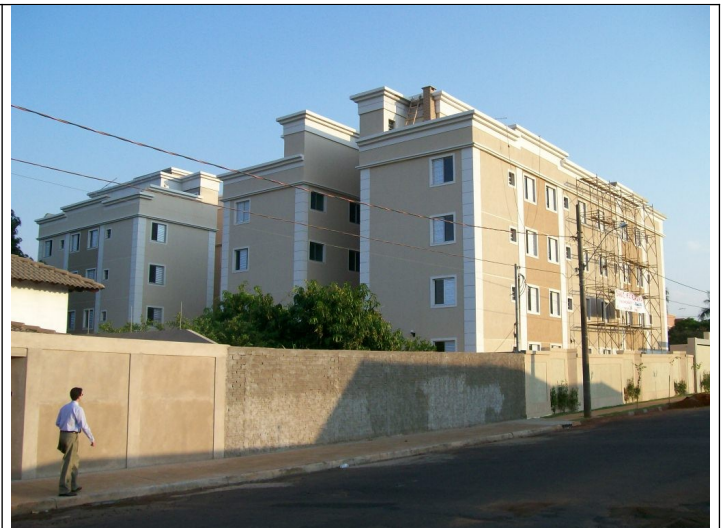
Figura 06 – Prédio de 4 pavimentos ( 5 se contando com a cobertura) , construído recentemente ao lado do Carmelo.
