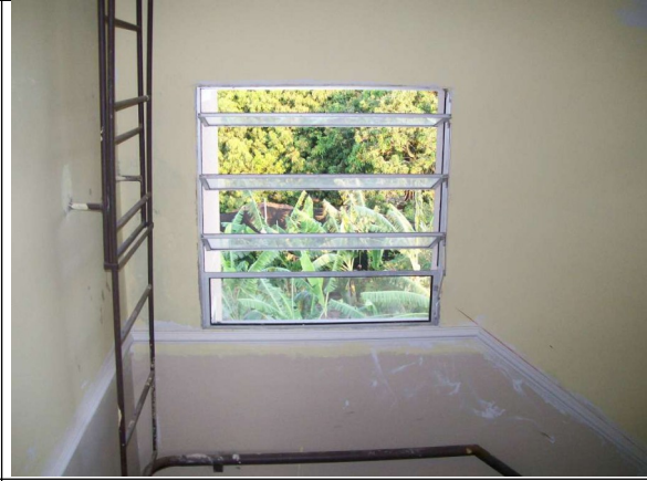
Figura 10 – Janela da circulação vertical do edifício de quatro pavimentos, através da qual se visualiza o interior do Carmelo.
