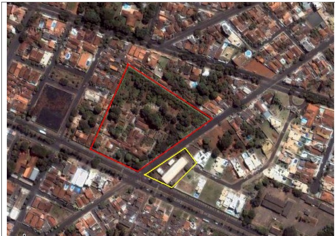
Figura 07 – Vista aérea do Carmelo Coração Eucarístico de Jesus (em vermelho) e seu entorno. Em amarelo, área onde está proposta a construção do prédio de 21 andares.
