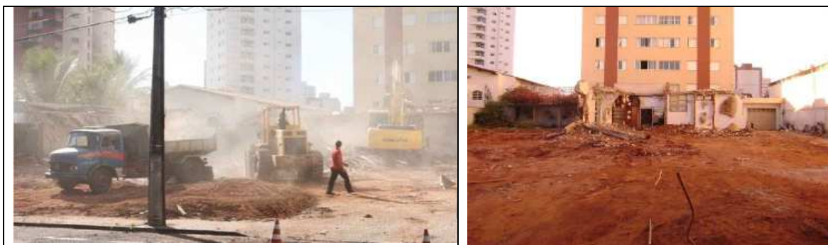
Figuras 05 e 06 – Demolição do imóvel em andamento e terreno resultante da demolição do imóvel. http://www.uberlandia.mg.gov.br/uploads/cms_b_arquivos/5517.pdf
