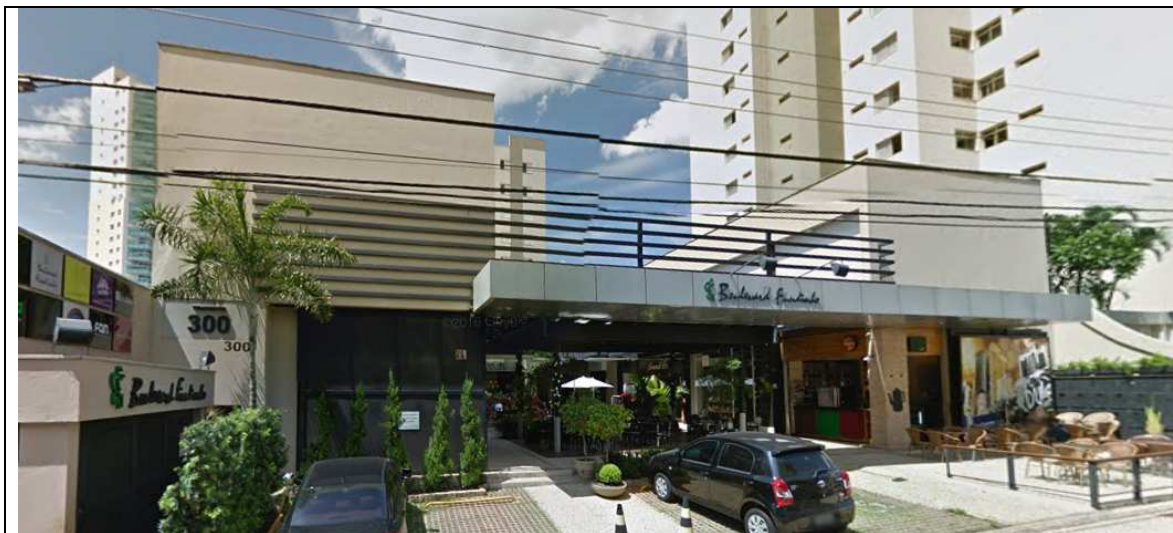
Figura 07 – Edificação construída no local.
