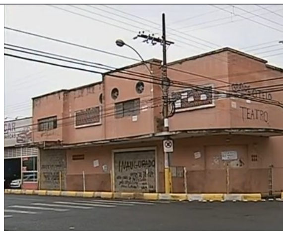
Figura 11 – Fachada do imóvel em 2014.
