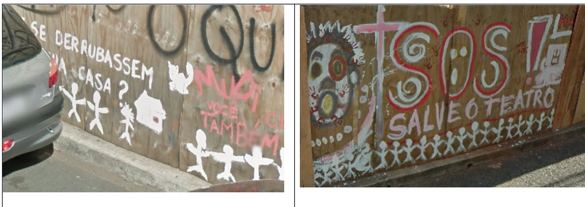
Figuras 02 a 04 – Fachada frontal do Teatro fechada por tapumes, 2012. Fonte: Google Maps Street View.
