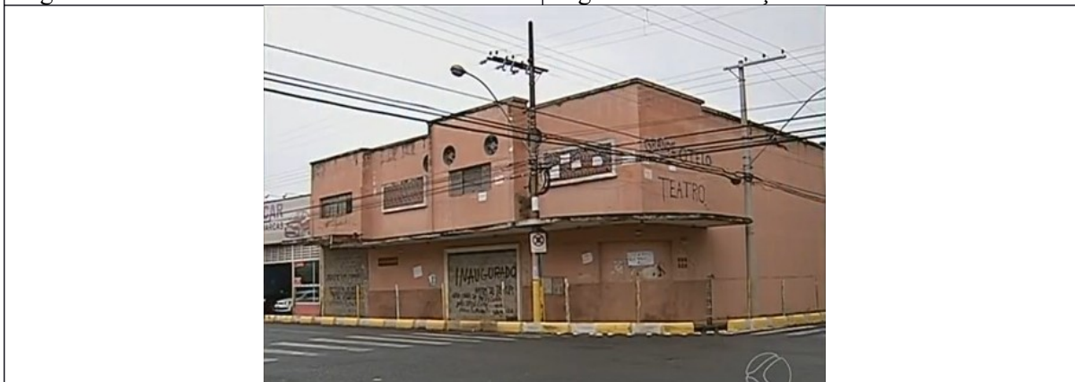
Figura 09 – A edificação em 2014.
