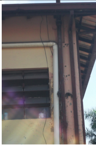
Figura 10 – Instalações hidráulicas externas à alvenaria.
