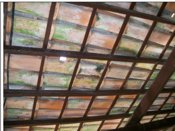
Figuras 27 e 28 – Buracos no telhado do anexo aos fundos do prédio.
