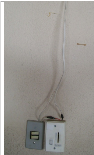
Figura 09 – Instalações elétricas externas à alvenaria.
