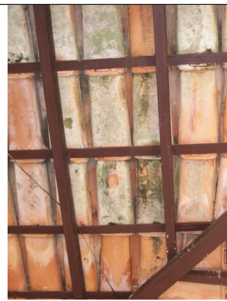
Figuras 27 e 28 – Buracos no telhado do anexo aos fundos do prédio.
