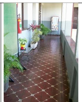
Figura 06 - Piso de ladrilho hidráulico nas circulações.
