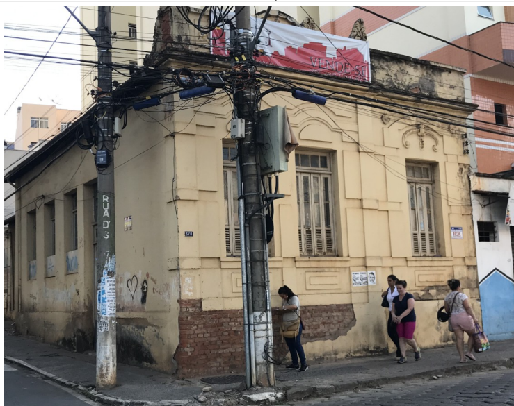
Figura 09 - Imóvel da na rua Bueno Brandão nº 370, recentemente demolido.
