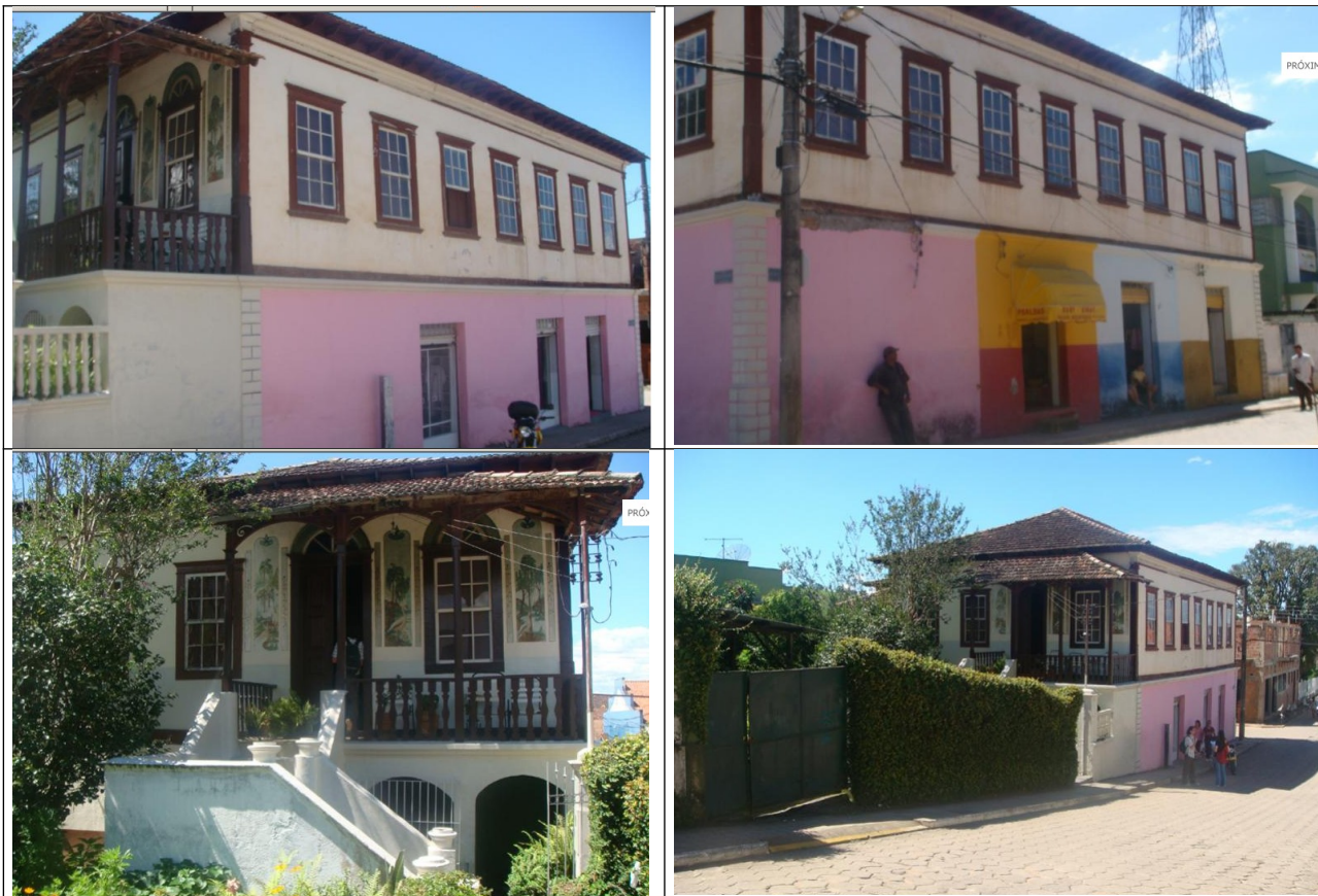
Figuras 06 a 09 – Imagens da edificação antes do início da demolição.
