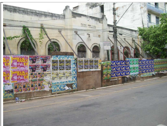
Figura 06 – Imagem da edificação em 26/11/2008.
