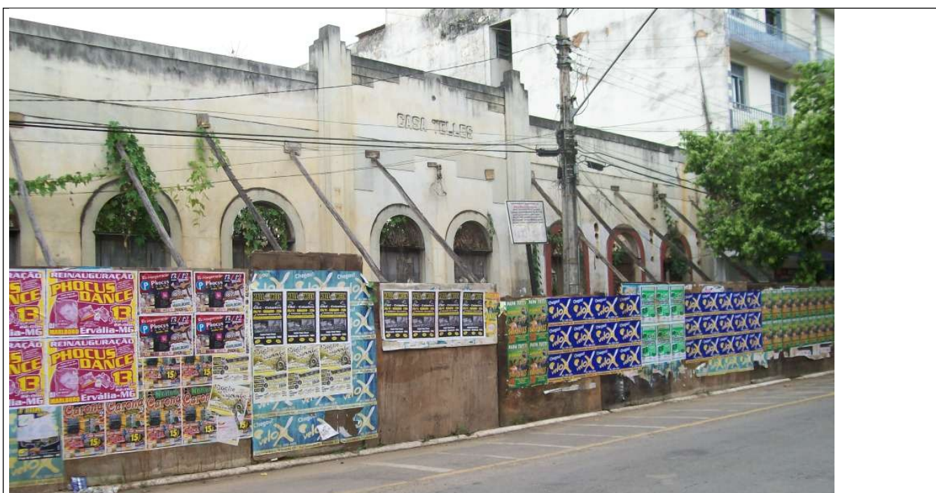
Figura 04 – Fachada da Casa Telles anterior à demolição.
