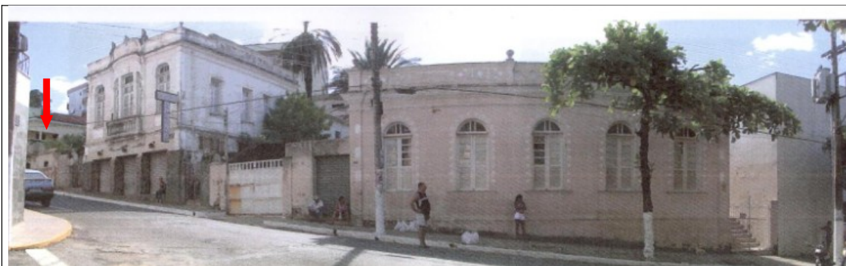
Figura 15 – Imagem do conjunto antes da demolição.
