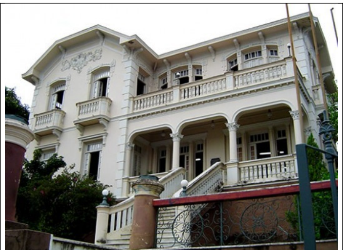
Figura 07 – Conservatório de Musica
