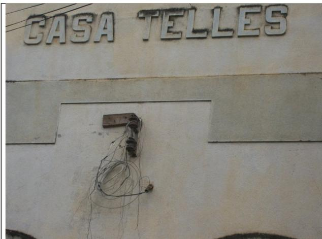
Figura 12 – Fiação elétrica aparente.
