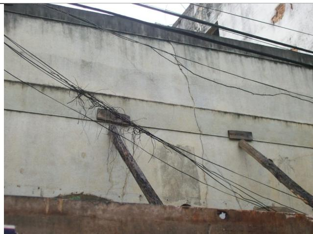
Figura 13 – Fiação elétrica em contato com a fachada.
