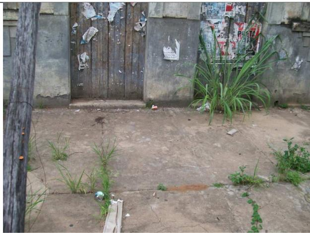
Figura 09 – Calçada com trincas, lixo e plantas invasoras.
