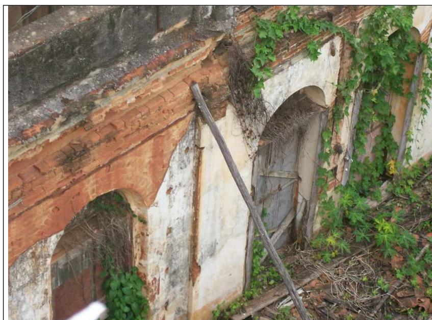
Figura 07 – Descolamento do reboco e manchas de umidade.
