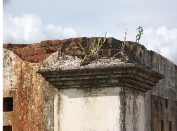
Figura 07 – Detalhe dos cunhais e da alvenaria de tijolos maciços cozidos.
