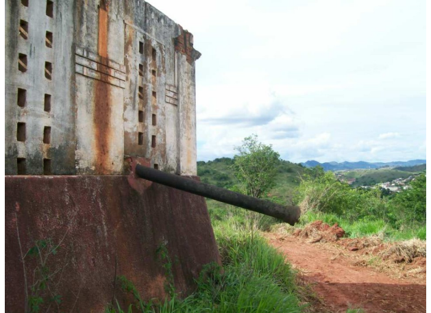
Figura 08 – Detalhe do embasamento chapiscado, dos ornamentos na alvenaria e da tubulação de ferro galvanizado ainda existente.
