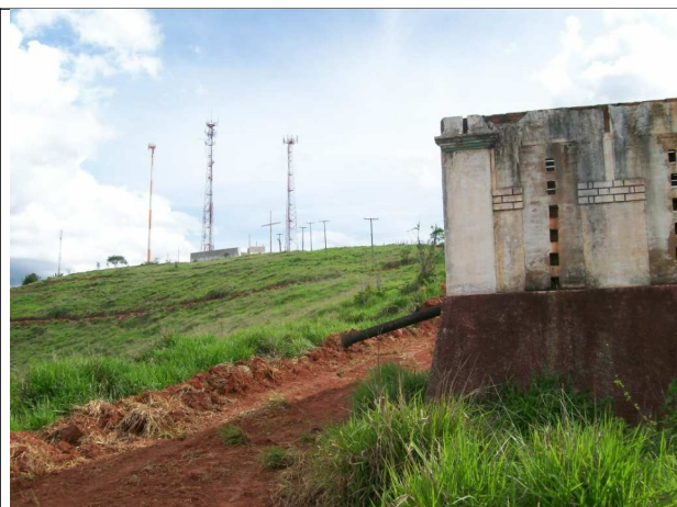
Figura 04 - Localização da caixa d'água em terreno desocupado próximo às antenas de telecomunicação.
